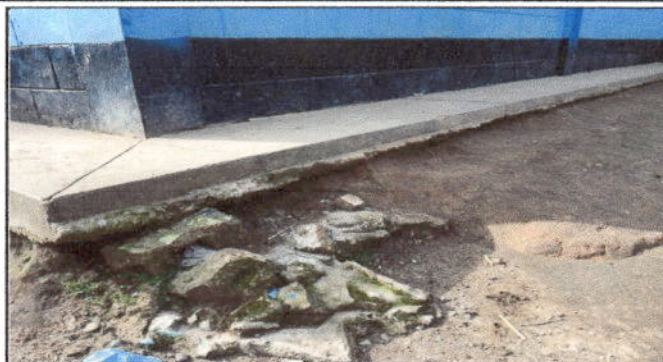
Foto 7: Reparación de banquetas de concreto. Modulo 1
