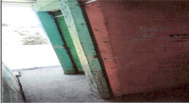
Foto 1: Sustitución de puertas en servicio sanitario. Modulo 4
