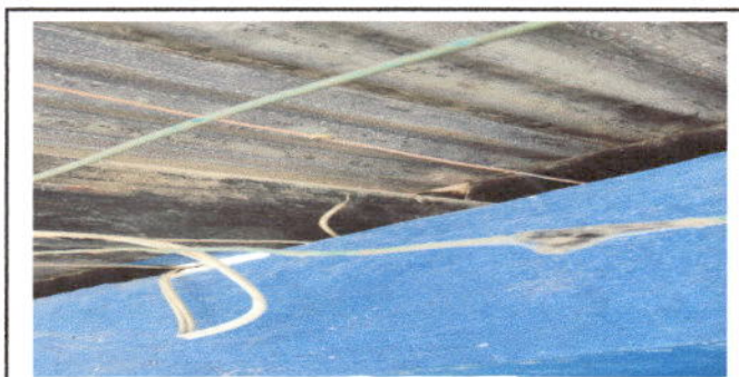
Foto 11: Reparación de cableado electrico modulo 1
