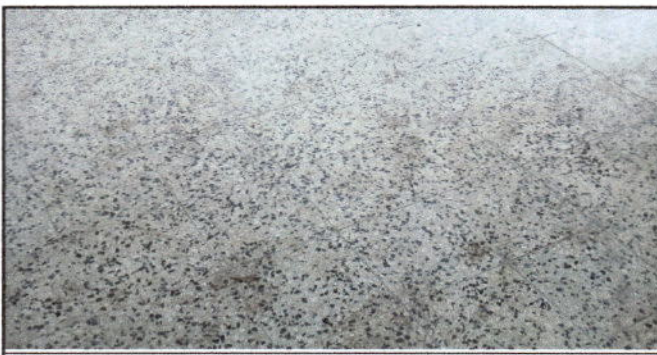
Foto 5: Mantenimiento de piso de granito (pulido y lustrado). Modulo 2
