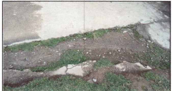
Foto 4: Sustitución de piso de concreto. Modulo 3
