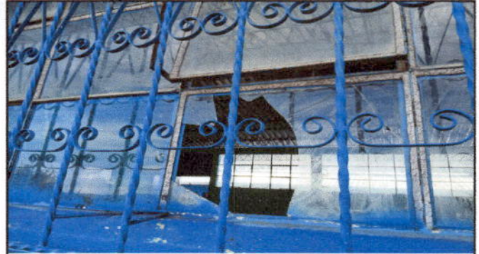
Foto 2: Sustitución de vidrios. Modulo 1
